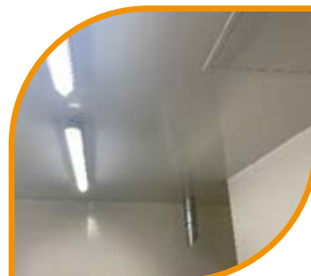
Réalisation et du plafond et installation d'un extracteur
