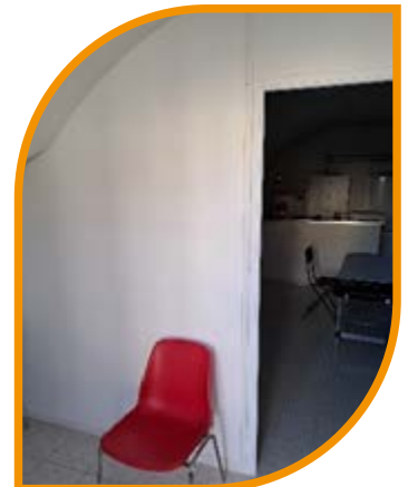
Création d'une cloison de séparation dans le local Santé
