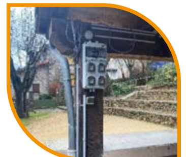
Remplacement d'un coffret électrique au four du village
